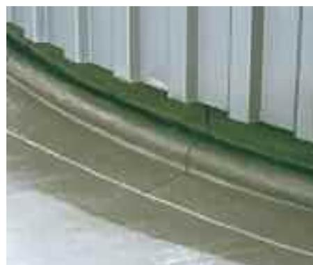
Applicazione di KEMPEROL® V210: l'applicazione è eseguita unicamente da personale appositamente addestrato. KEMPEROL® V210 consente di impermeabilizzare con un manto continuo ed omogeneo gronde, esalatori e qualsiasi volume tecnico senza nessun problema.
