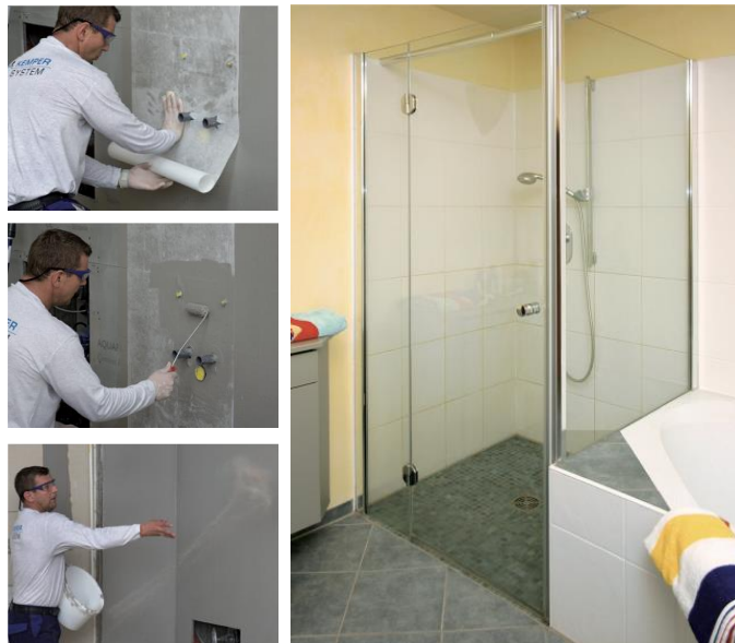
Fasi realizzative del sistema impermeabile KEMPEROL 022 in un vano doccia.
