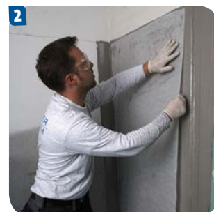
Le voile textile absorbant est déroulé dans la résine fraîche
