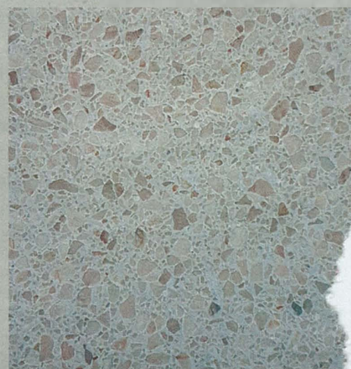
▼ Pour ce chantier, l'Artekem se compose d'une résine teintée blanche, coloris 9001, et de granulats de marbre Botticino.
