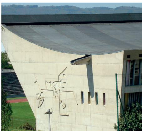
système d'étanchéité en place est, quant à lui, déposé. Afin d'améliorer les performances thermiques de l'ouvrage, un isolant en laine de roche de 120 mm est mis en œuvre sur un pare-vapeur. Le complexe est ensuite renforcé par une chape en bitume armée de 40 mm d'épaisseur soudée à chaud sur l'isolant avant le collage à froid d'une membrane en EPDM. Un choix de matériau justifié par son élasticité, adaptée à la souplesse et aux
