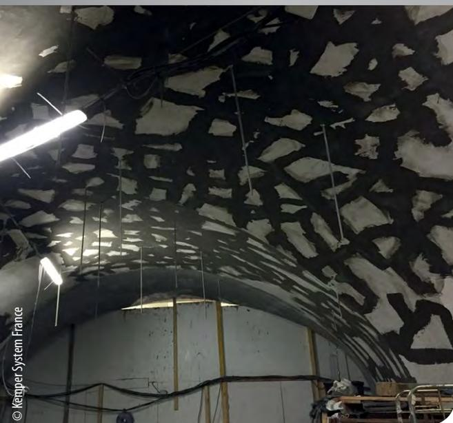
Les fissures ont été reprises sur l'intégralité de la surface de travaux afin de préparer le support à recevoir le système d'étanchéité liquide Kemperol CEV.
