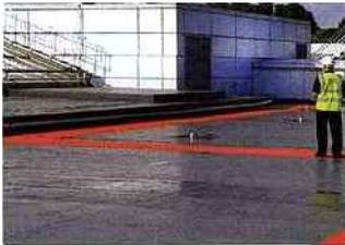
Cette solution associe une étanchéité liquide (Kemper System) et un complexe d'isolation (Recticel Insulation) pour toitures-terrasses et toits plats. Complexe constitué d'un panneau d'isolation thermique en mousse rigide PIR, et revêtu de parements en composite alu et d'une étanchéité liquide à base de résine polyuréthane sans solvants, formant une membrane monolithique de 2 mm. Mise en œuvre possible avec pare-vapeur traditionnel sur maçonnerie ou support bois, en neuf ou en rénovation. ATE.
