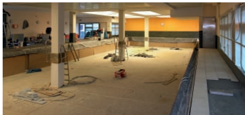
Der still gelegte Sportpool während der Sanierung. Der gesamte Randbereich wurde mit KEMPEROL® abgedichtet.
