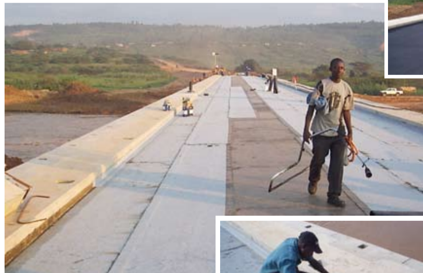
Alle Anschlüsse der ruandischen Brücke wurden mit KEMPEROL® BR abgedichtet.
