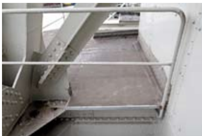
Im Bereich aufgehender Bauteile wurde die Abdichtung mindestens 15 cm hochgezogen.
