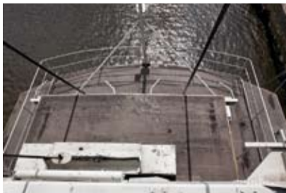
Blick von oben auf eine KEMPEROL®-Fläche. Alle waagerechten Flächen des Schwimmkrans wurden mit KEMPEROL® abgedichtet.
