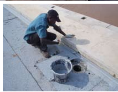
Alle Anschlüsse der ruandischen Brücke wurden mit KEMPEROL® BR abgedichtet.
