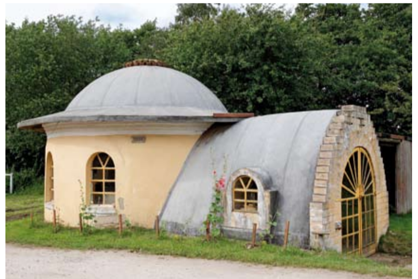
Ebenfalls in Lehm- oder Ziegelbauweise errichtet und mit KEMPEROL® abgedichtet wurde dieser Kuppelbau, in dem Lehm- oder Ziegelbau unterrichtet wird.
