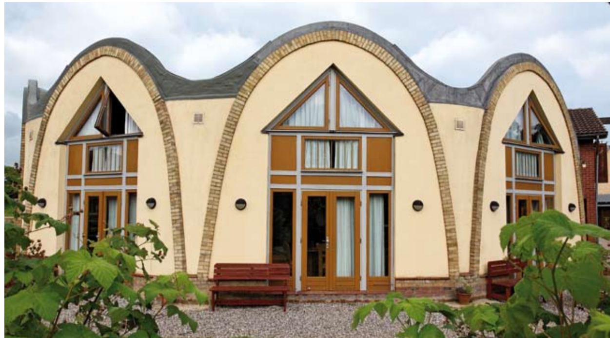
Die Rundung der nubischen Gewölbe des Gästetraktes ist von außen gut sichtbar.
