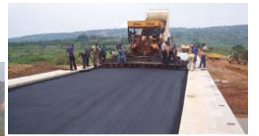
Als verschleißfeste Nuttschicht wurde ein bituminöser Fahrbahnbelag aufgezogen.
