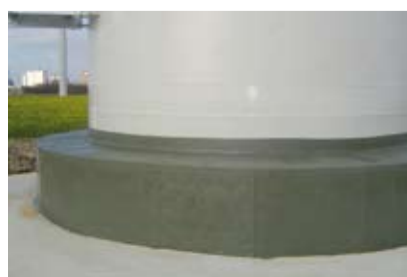
KEMPEROL® ist hervorragend geeignet für den Einsatz auf runden Turmsockeln, da es sich aufgrund der flüssigen Verarbeitung jeder Untergrundform anpasst.
