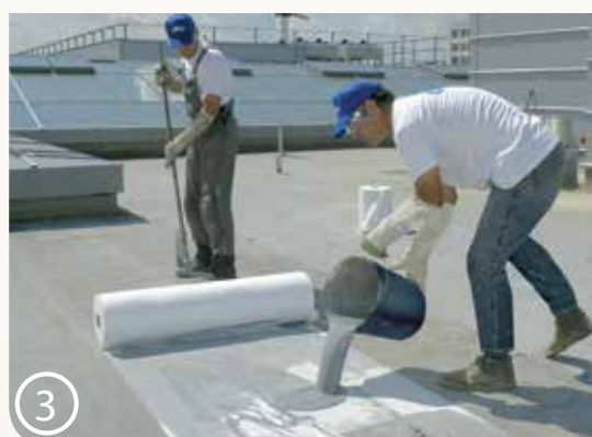
3 La seconda mano di resina KEMPEROL® è applicata, a prima mano ancora liquida, sul tessuto per saturarlo di resina
